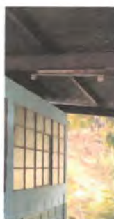
Foto 5: Sustitución de sistemas de iluminación: Lámparas.
