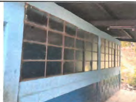
Foto 4: Sustitución de ventanas; sistema de apertura: Corredizas, Perfiles color blanco estandar, Material del marco: PVC Material de la ventana: Vidrio, sellado perimetral.
