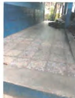
Foto 2: Sustitución de piso de granito en mal estado, por piso de granito.
