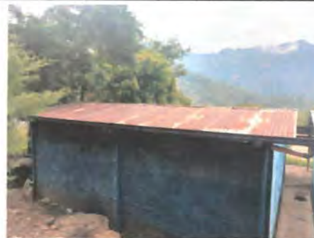
Foto 6: Sustitución de cubierta de techo con lámina galvanizada, Tipo de lámina: troquelada Calibre: 26, incluye: fijaciones y sellado en traslapes.
