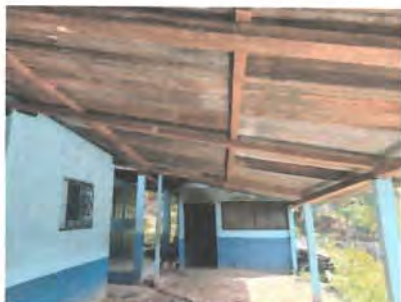
Foto 1: Sustitución de estructura metálica para soporte de cubierta de lámina incluyendo perfiles para vigas, travesaños, sujeta con tornillería; corte, soldadura y anclaje de la estructura portante.
